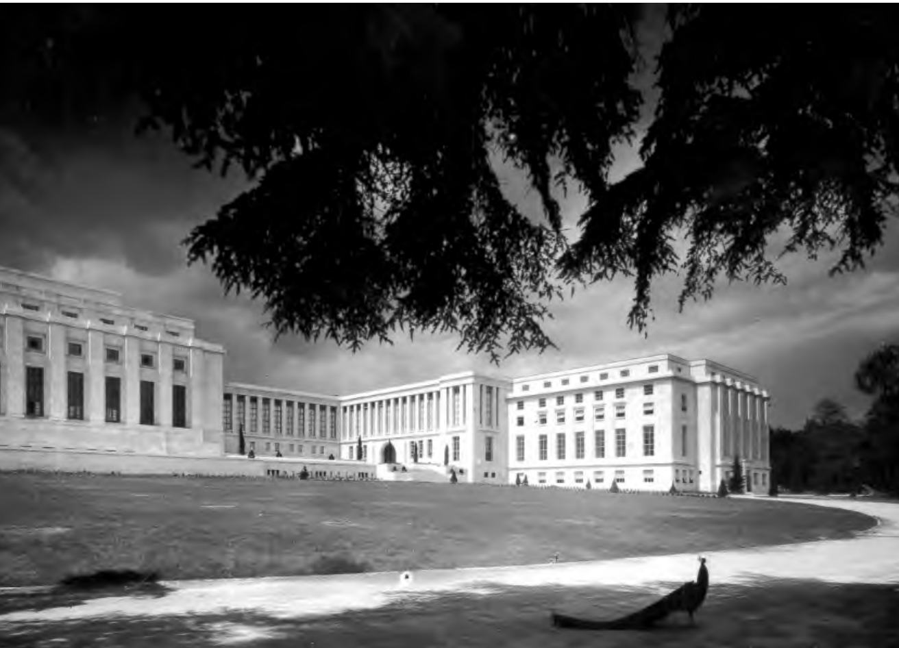
Vue de la cour d'honneur du Palais des Nations avant l'installation de la Sphère armillaire, s.d., Archives des Nations Unies à Genève.
