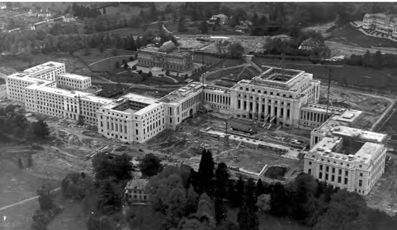
Construction du Palais des Nations, moitié des années 1930, Archives des Nations Unies à Genève.
